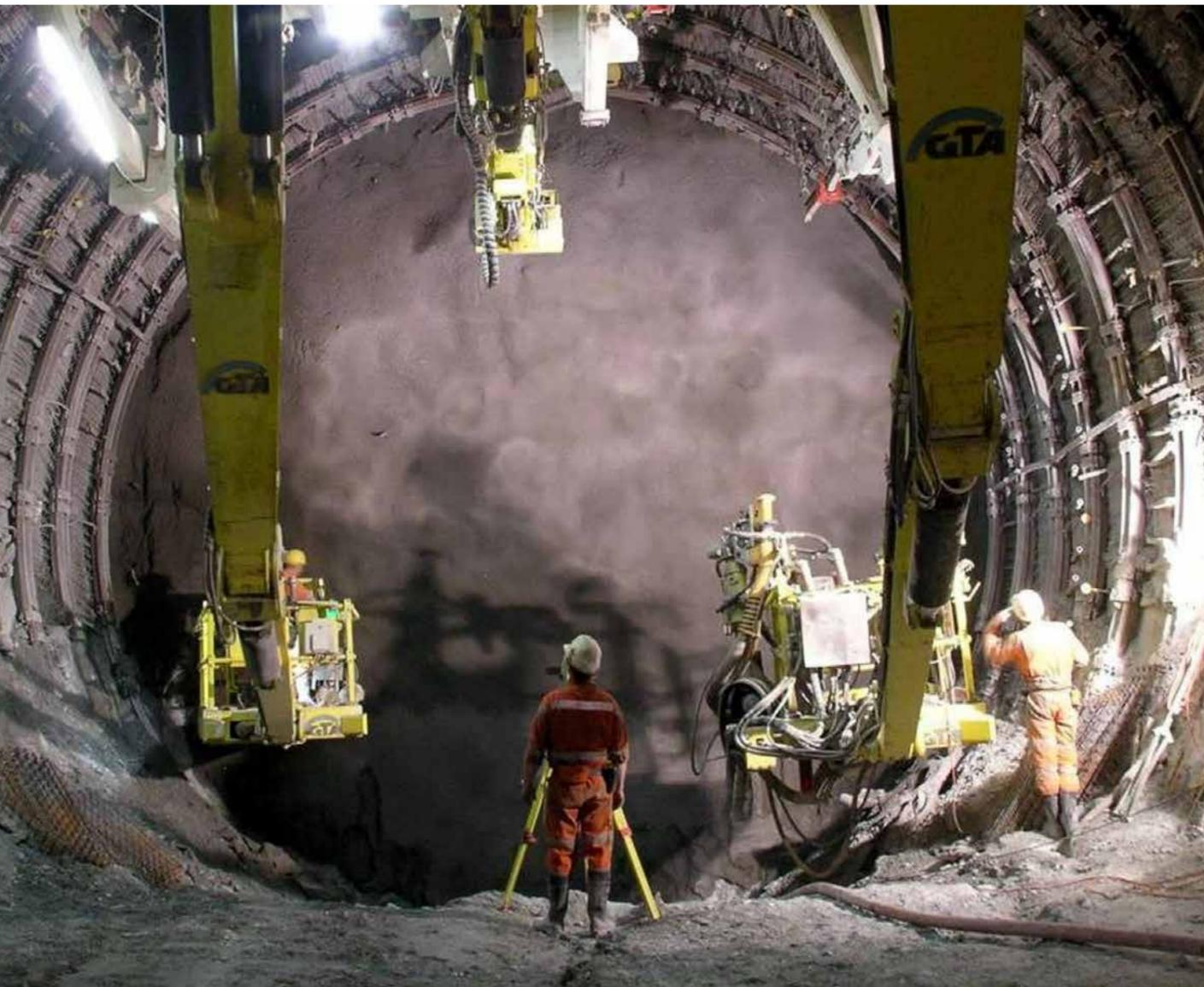
**„Allein in die Sanierung des Arlbergtunnels investiert die ASFINAG in den kommenden zwei Jahren 75 Millionen Euro. Neben der kompletten Erneuerung der Fahrbahn werden auch Tunnelbeschichtung und Entwässerung saniert.“**
