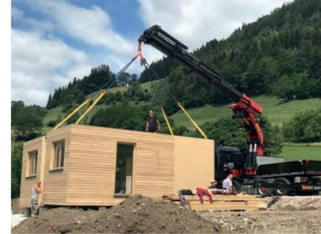
Der PALFINGER PK 165.002 TEC 7 erreicht eine bis zu 15% höhere Traglast als sein Vorgänger.
